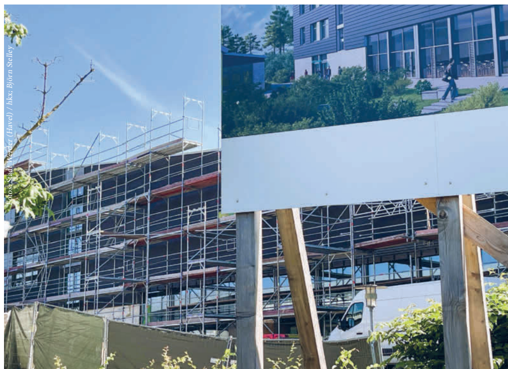
Die Fassadenverkleidung verbirgt sich noch hinter dem Baugerüst.
