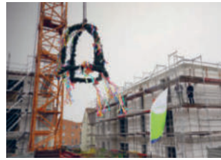
Am Schwalbenbergweg wurde bereits das Richtfest gefeiert.
