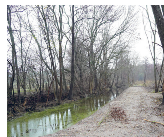
Neben dem Abzugsgraben fanden Sicherungsarbeiten statt.
