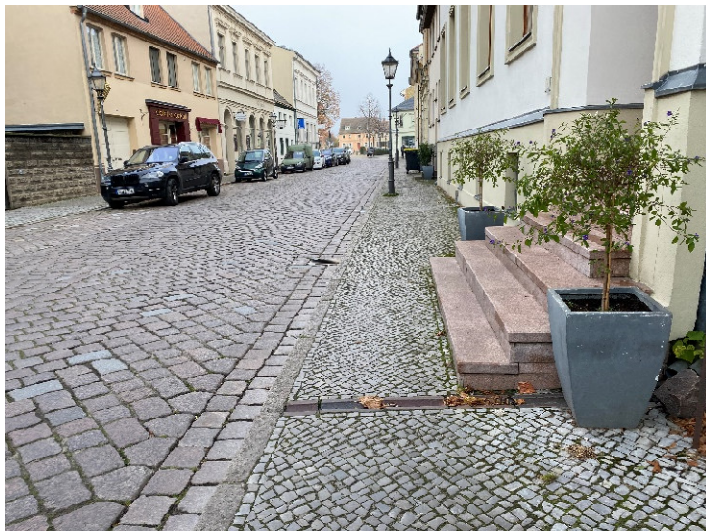
Foto 5: Blick in die „Torstraße“ Standpunkt südlicher Gehweg östlich der Kreuzung „Torstraße“/„Uferstraße“. Treppen der Hauseingänge und Laterne engen den Gehweg ein. Die offenen Regenrinnen stellen eine Stolpergefahr dar.
