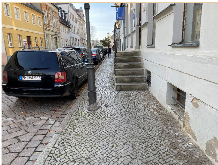
Foto 6: Blick in die „Torstraße“ Standpunkt nördlicher Gehweg westlich der Kreuzung „Torstraße“/„Am Markt“. Treppen der Hauseingänge und Laterne engen den Gehweg ein. Die Laterne steht hier mitten in der Lauflinie.
